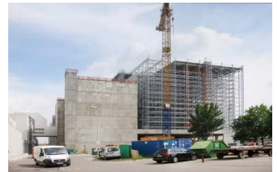
Neubau Hochregallager, Audi AG, Ingolstadt
