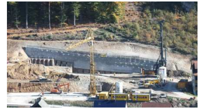
Hotel-Sponsel-Regus, Heiligenstadt, Baugrubensicherung
