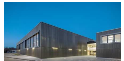
Neubau Dreifachturnhalle, Beilngries
