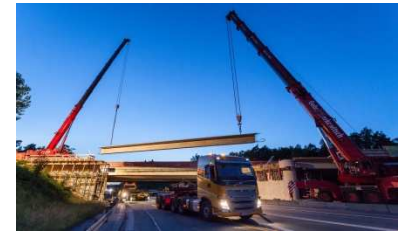
BAB A3, Frankfurt-Nürnberg Teilerneuerung Überführung
