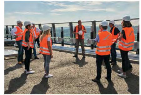
Bei bestem Sommerwetter erkundeten die Teilnehmerinnen und Teilnehmer die Besonderheiten der Hochmoselbrücke.
