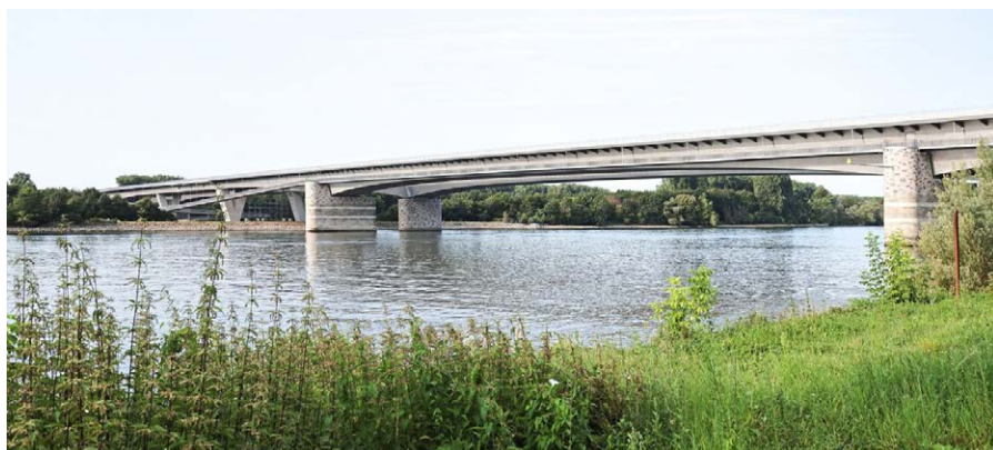
Die Schiersteiner Brücke zwischen Wiesbaden und Mainz ist eines der Finalisten-Projekte des deutschen Brückenbaupreises 2025. Foto: ©Frank Heinen
